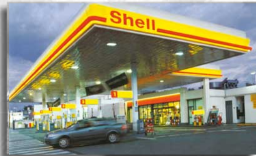
Carga de Combustible
